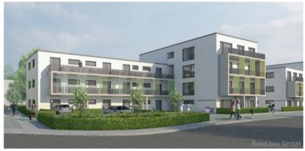
In Modulbauweise von der Firma Solid.box errichtet ist dieses Mehrfamilienhaus in Niedersachsen. Wärmequelle ist eine Infrarotheizung mit einer PV-Anlage mit dem Standard KfW-Effizienzhaus 40 plus.
