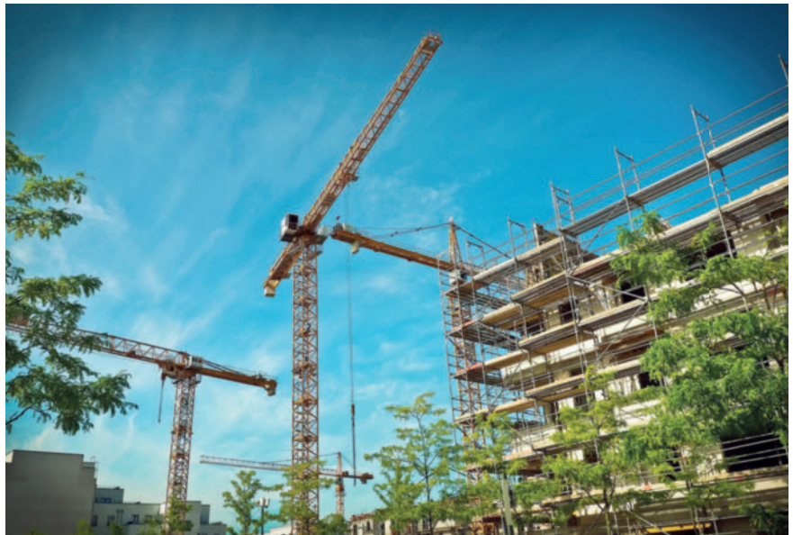
Der Wille ist da, baureife Flächen auch, doch vielerorts stehen die Baukräne still.
